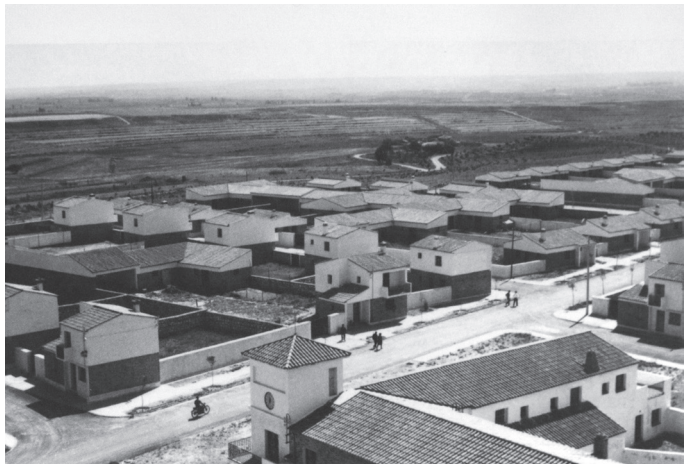
FIGURA 15: Vista general: diversidad tipológica
