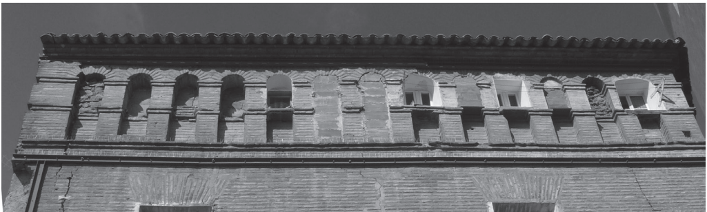
FIGURA 11: Arquillos en el piso superior o mirador
