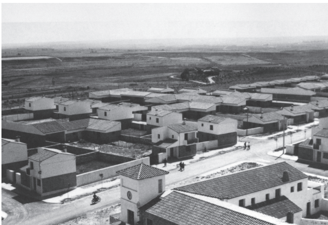
FIGURA 15: Vista general: diversidad tipológica
