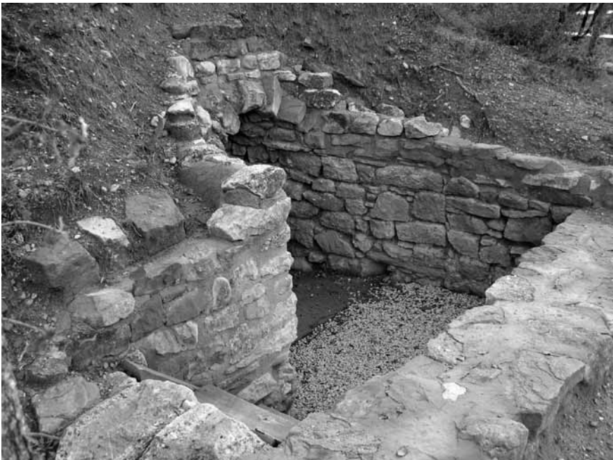
FIGURA 13: Acceso al pozo de hielo de Getsemaní III tras su limpieza y rehabilitación
