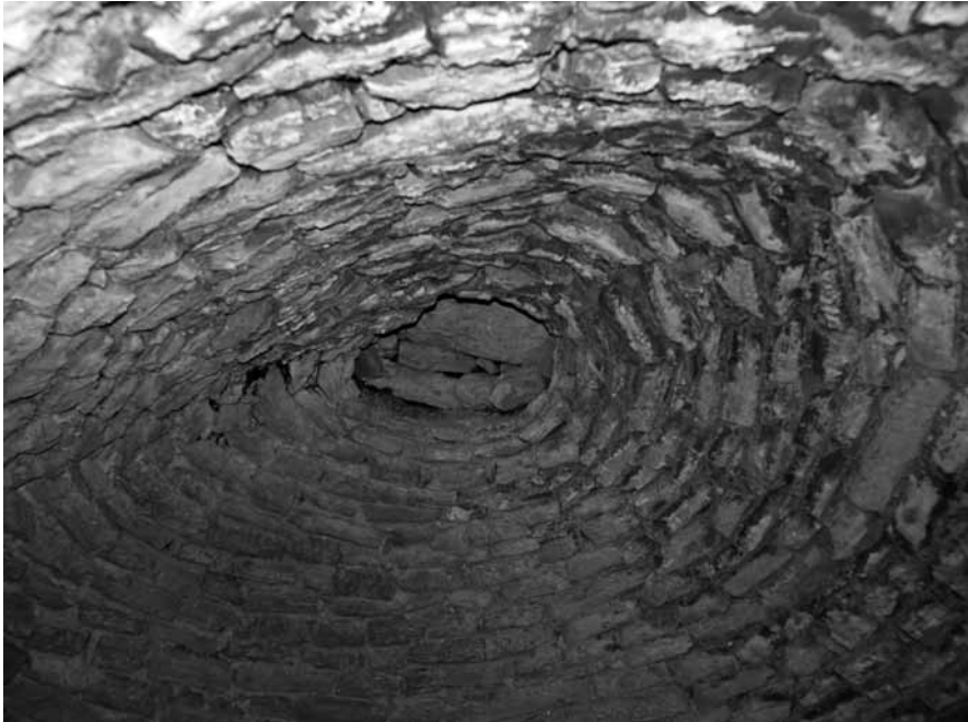
FIGURA10: Bóveda de piedra unida con argamasa en el pozo Getsemaní III
