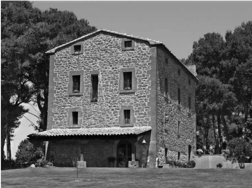
FIGURA 9: Torre Moncasi d'Albelda
