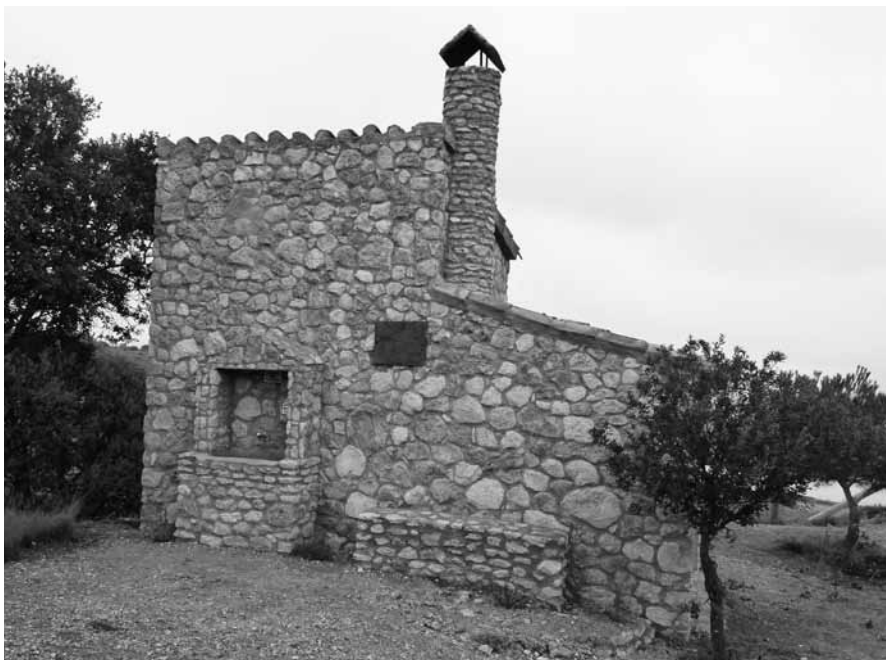
FIGURA 7: Vista del refugio Benito Coll en la Sierra
