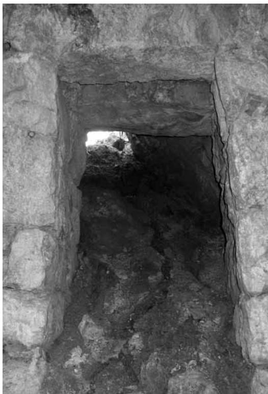
FIGURA 3: Túnel para introducir la nieve y el hielo en el pozo de Calasanz
