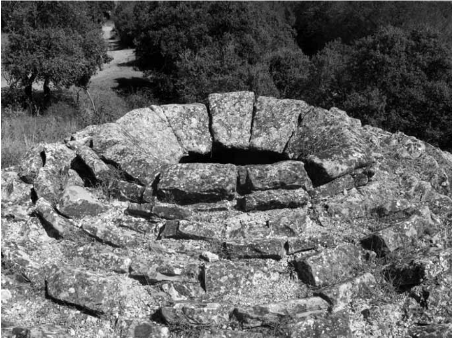
FIGURA 2: Original ventana en forma de embudo para empozar. Pozo de hielo de Calasanz
