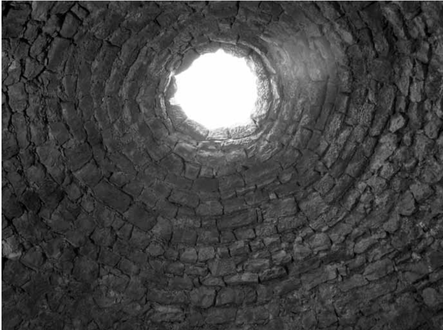
FIGURA 1: Interior de la bóveda de la nevera de Calasanz, construida por aproximación de hiladas
