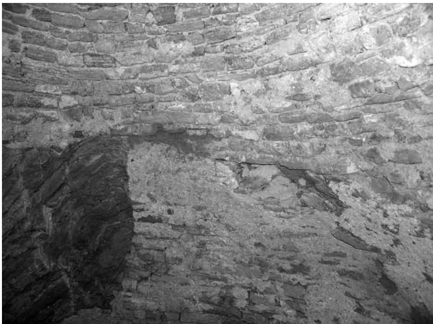
FIGURA 9: Nevera Getsemaní III. Detalle de la pared donde se observa la parte de la roca rebajada y el trabajo de cantería
