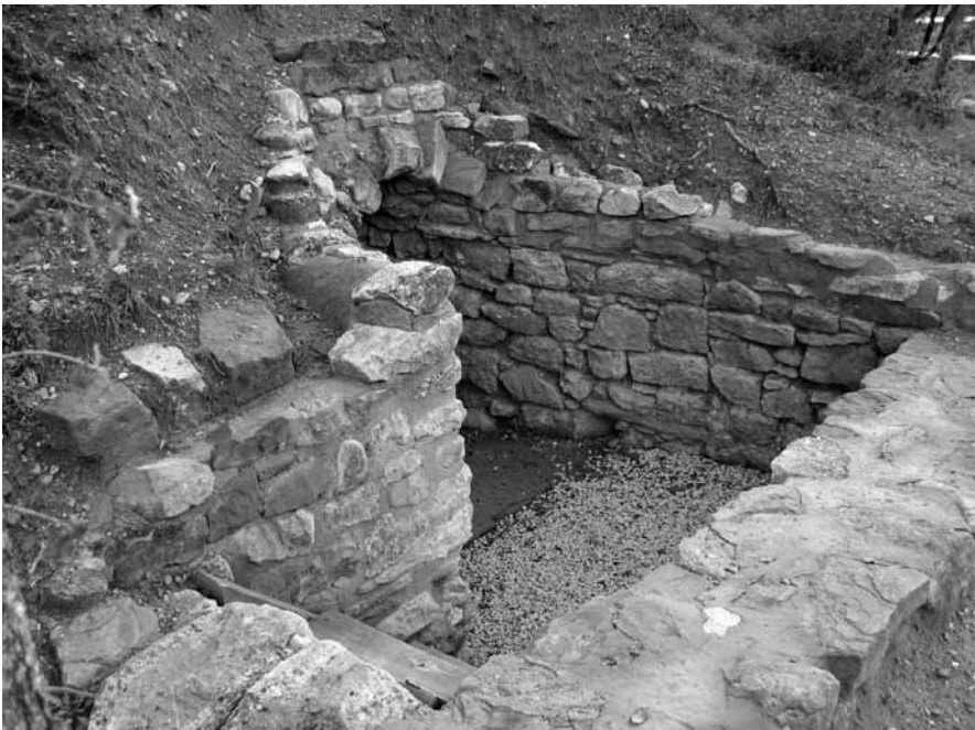
FIGURA 13: Acceso al pozo de hielo de Getsemaní III tras su limpieza y rehabilitación
