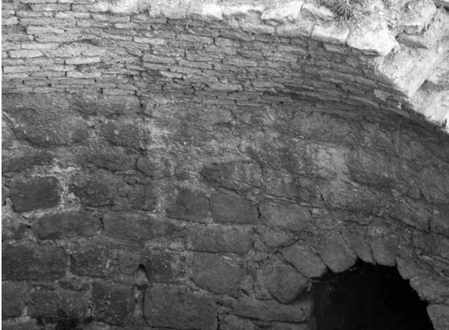
FIGURA 4: Nevera de Peralta de la Sal, construida con sillares de arenisca y bóveda de ladrillo
