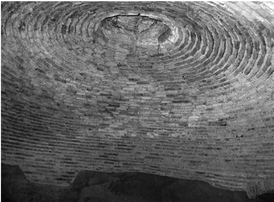
FIGURA 5: Bóveda de la nevera de Baells I, construida con ladrillos
