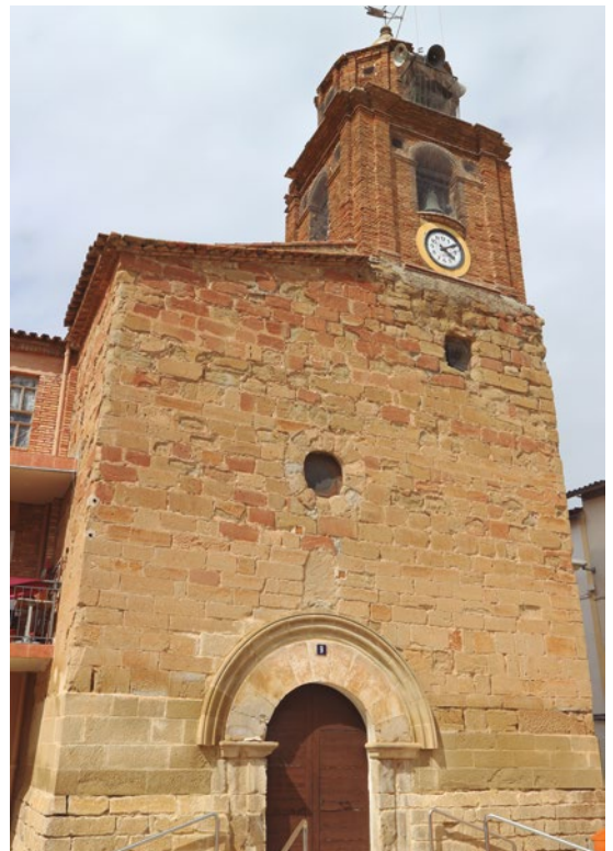
Figura 80: Vista del conjunto del campanario y la iglesia
