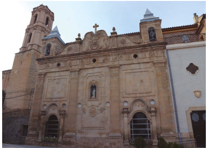
Figura 111: Vista de la Casa Natalicia y la iglesia de Santa María
