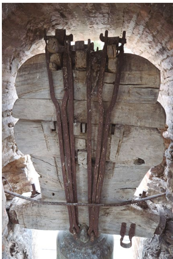
Figura 52: Yugo de madera para el bandeado de la campana grande de la iglesia de Castillonroy
