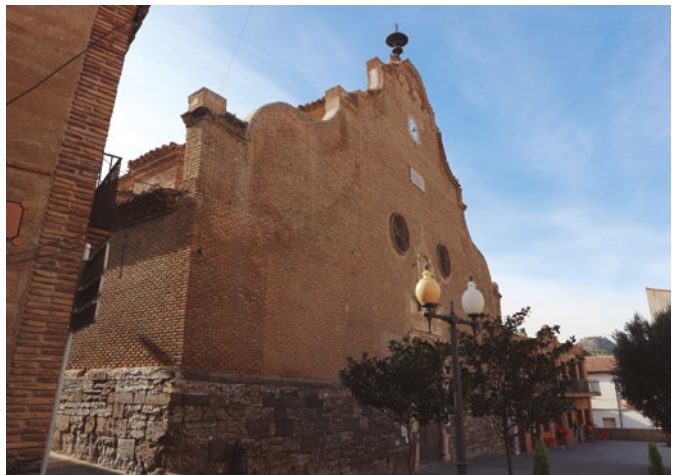
Figura 114: Vista de la iglesia
