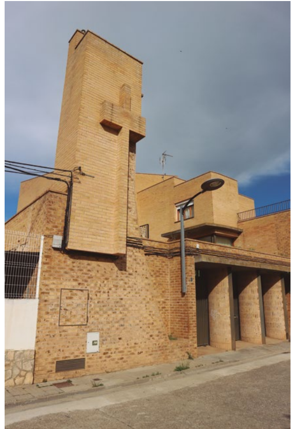
Figura 96: Campanario de la iglesia de San Antonio
