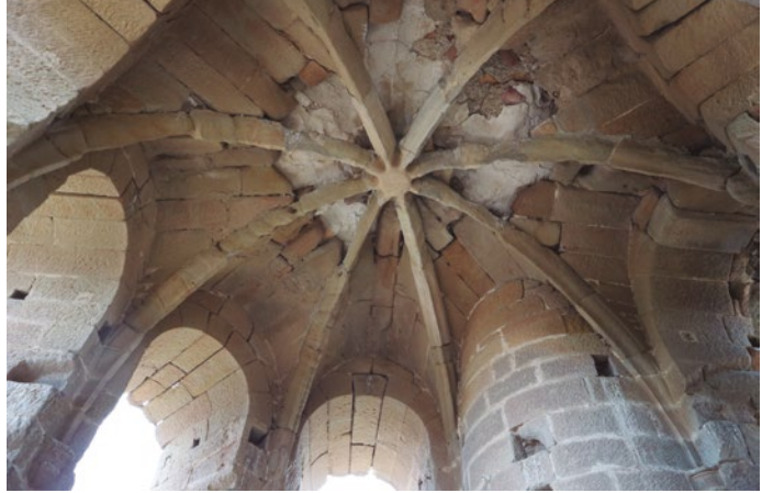
Figura 7: Bóveda de crucería de la sala de las campanas del campanario de Albelda (s. XVI)
