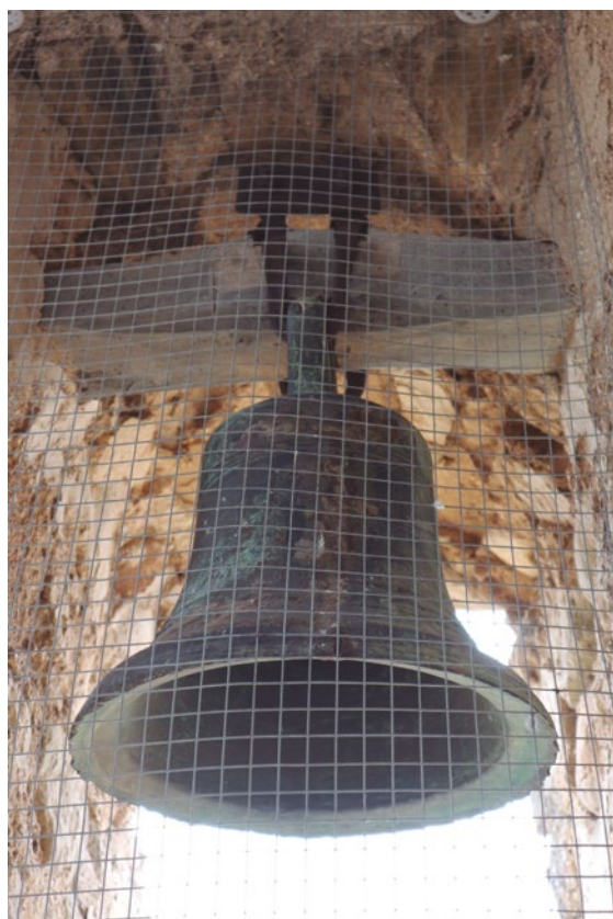
Figura 53: Sencillo yugo de madera para una campana fija. Iglesia de Calasanz
