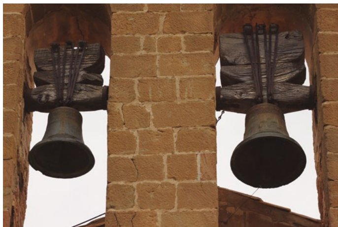
Figura 54: Campanas con su instalación tradicional de la iglesia de Alins del Monte
