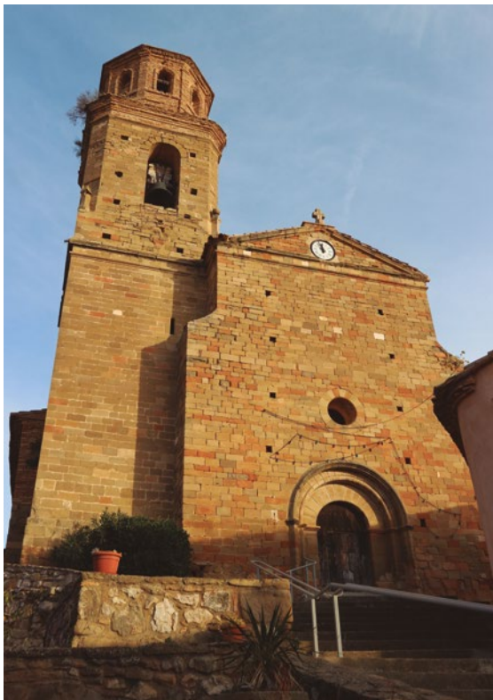
Figura 106: Vista del campanario
