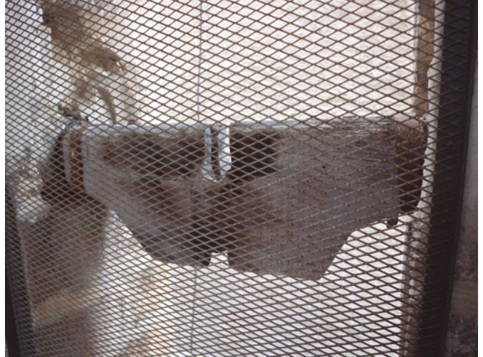
Figura 110: Brazo del yugo de una campana pequeña, destruida seguramente durante la Guerra Civil
