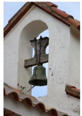
**Propuestas de conservación:** La instalación se debe conservar y restaurar. Las piezas que por estado de conservación no se puedan restaurar deben cambiarse por otras de igual forma. Puede mecanizarse con motor de volteo por impulsos.
