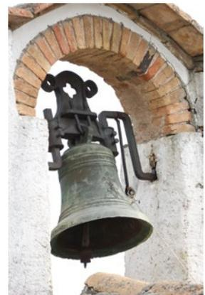
**Propuestas de conservación:** El yugo de hierro actual debería cambiarse por otro de madera de perfil similar al de otras campanas de la zona. Se podría motorizar con motor de bandeado por impulsos.
