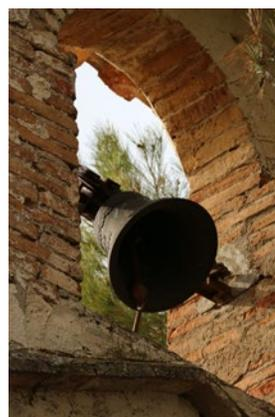
**Propuestas de conservación:** El yugo de hierro actual debería cambiarse por otro de madera de perfil similar al de otras campanas de la zona. Se podría motorizar con motor de bandeo por impulsos.
