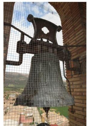
**Propuestas de conservación:** El yugo de hierro actual debería cambiarse por otro de madera de perfil similar al de otras campanas de la zona. Se podría motorizar con motor de bandejo por impulsos y electromazo.
