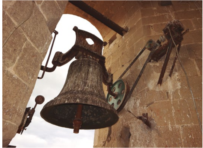
Figura 56: Campana grande de la iglesia de San Pedro de Binéfar, con yugo de hierro y mecanismos para el toque automático
