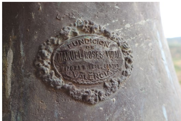
Figura 46: Marca de fábrica de la fundición de Manuel Roses Vidal en la campana grande de la iglesia de Peralta de la Sal (1947)
