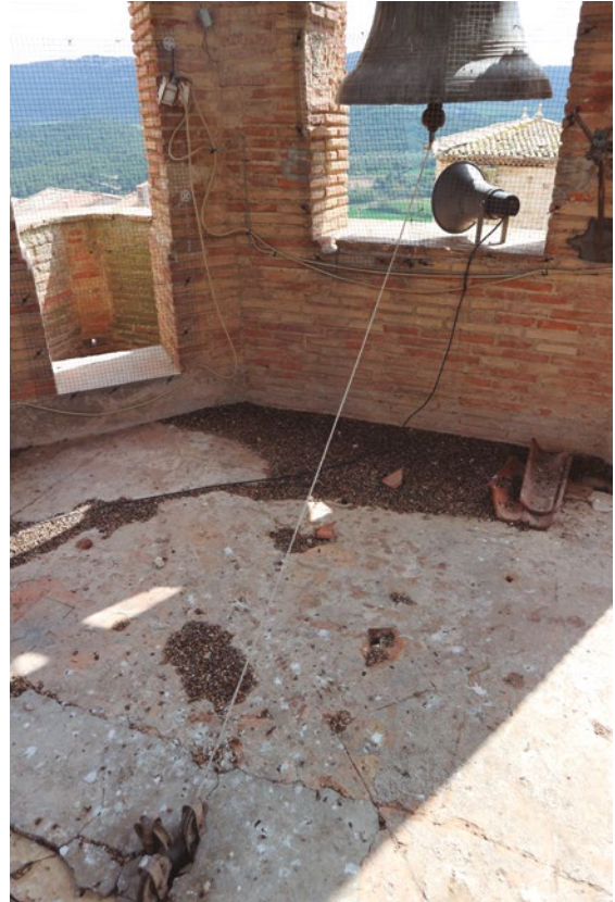
Figura 59: Cuerda unida al badajo de la campana grande de Baldellou. Mediante una polea pasa la cuerda hacia el interior de la torre
