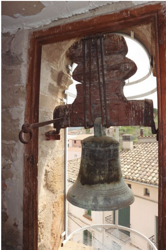
Figura 57: Campana con ejes acodados y palanca para oscilar. Casa natalicia de San José de Calasanz de Peralta de la Sal
