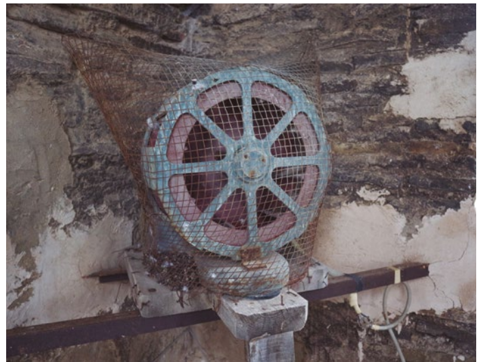
Figura 61: Sirena instalada en la iglesia de Azanuy
