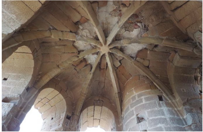
Figura 7: Bóveda de crucería de la sala de las campanas del campanario de Albelda (s. XVI)
