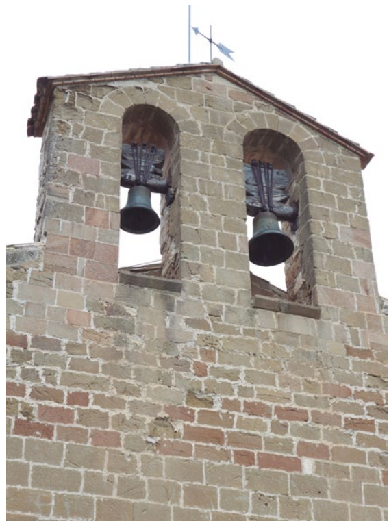
Figura 3: Espadaña de la iglesia de Alins
